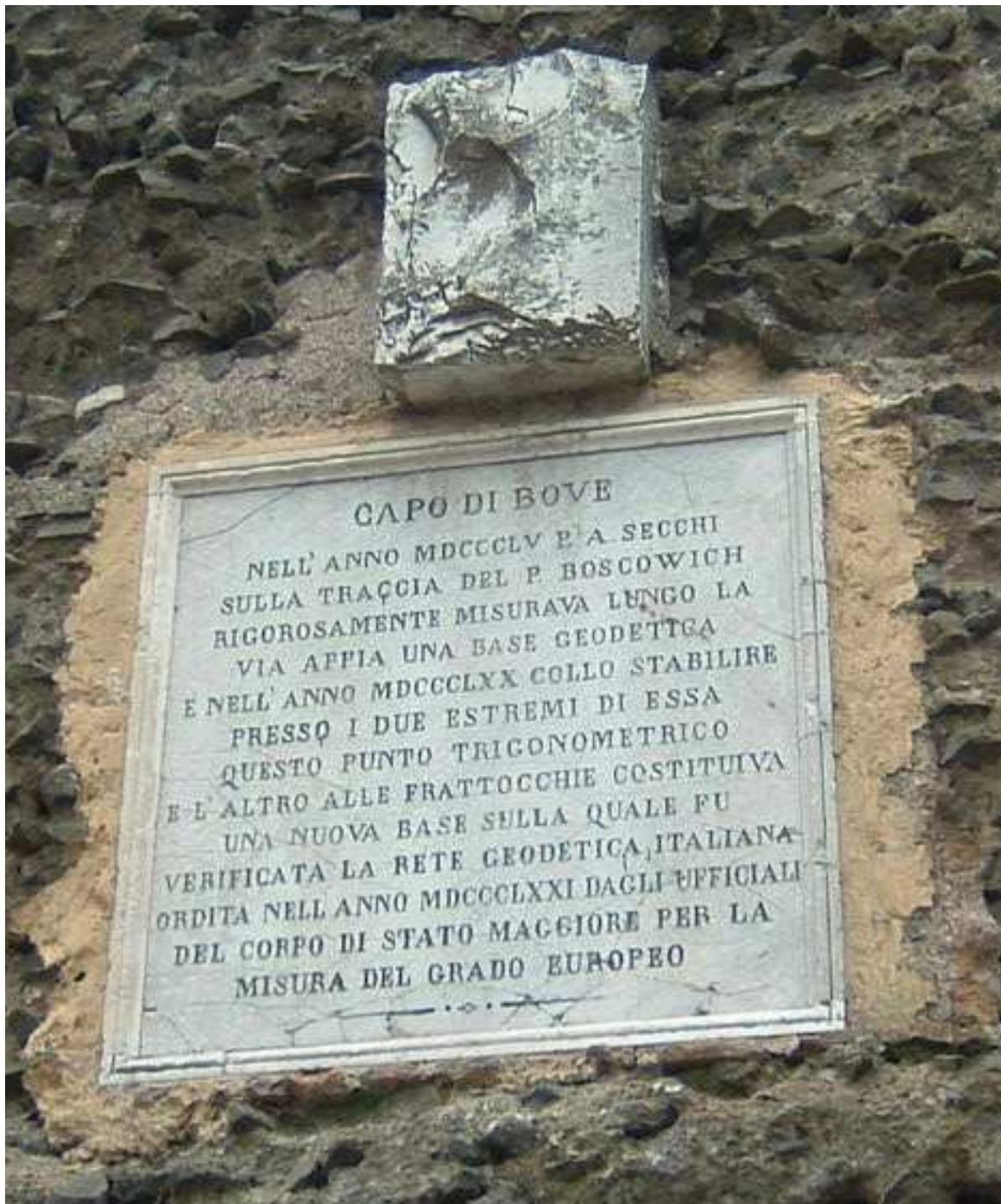
Fig. I.7 – Estremo della base geodetica sita lungo la via Appia da Capo di Bove (cui si riferisce l'immagine) alle Frattocchie misurata e rimisurata rispettivamente dai P.P. Ruggero Giuseppe Boscovich ed Angelo Secchi nell'ambito della misura dell'arco di meridiano terrestre tra Roma e Rimini<sup>9</sup>
